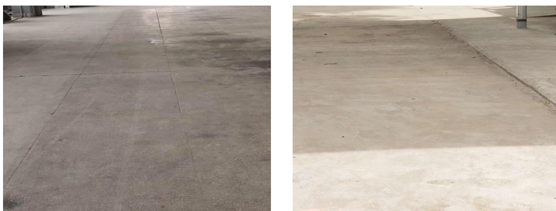
图 7 厂房现场情况及地面硬化情况图
